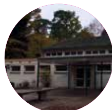
SPORTHALLE JOSEF Mastbruchstraße 77, 33104 PB
